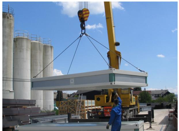
Handling von modularen Einheiten mit einem Kran
